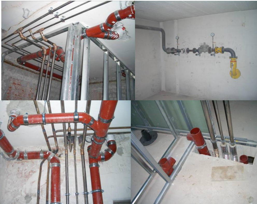
detalles de instalaciones sanitarias durante fase de construcción
